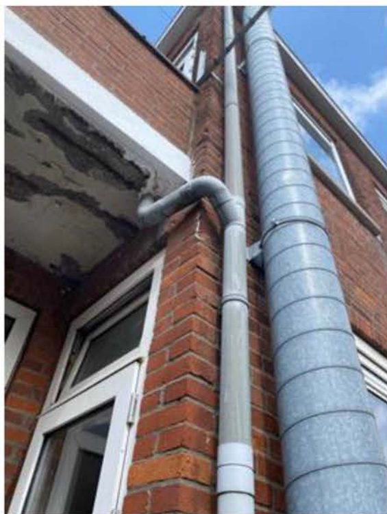
Foto 26. Aanzicht standleiding hemelwaterafvoer.
