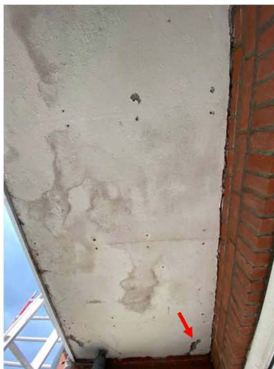
Foto 22. Onderaanzicht balkon 260 met betonschade.
