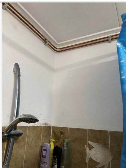
Licht scheur in wand badkamer
