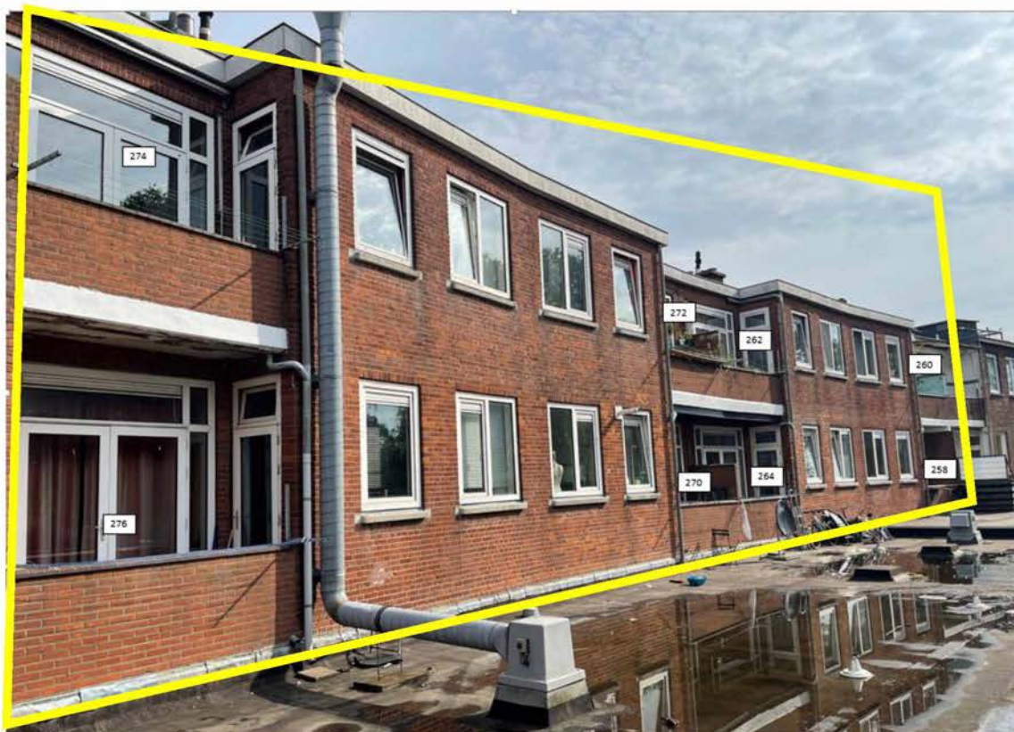
Foto 1. Aanzicht achtergevel met de desbetreffende balkons en bijbehorende huisnummers.
