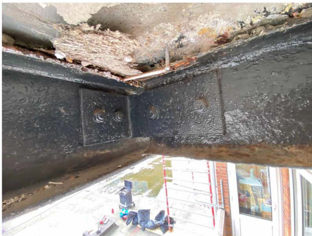
Foto 3. Locatie stalen uitbrenger (SU-1) aansluiting uitbrenger / stalen balk onder randbalk.
