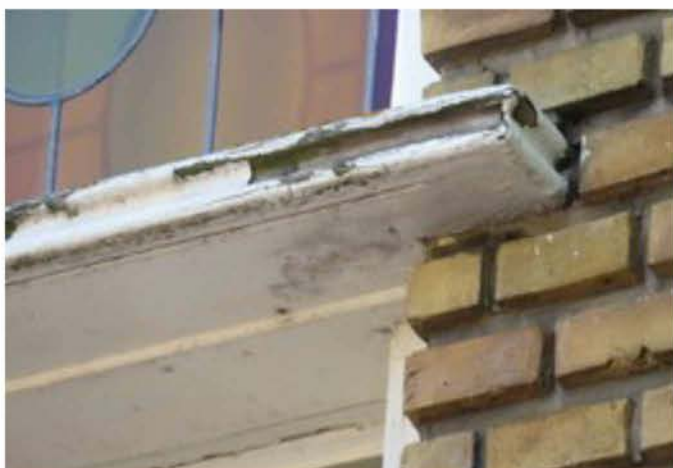
Detail kalf raamkozijn
