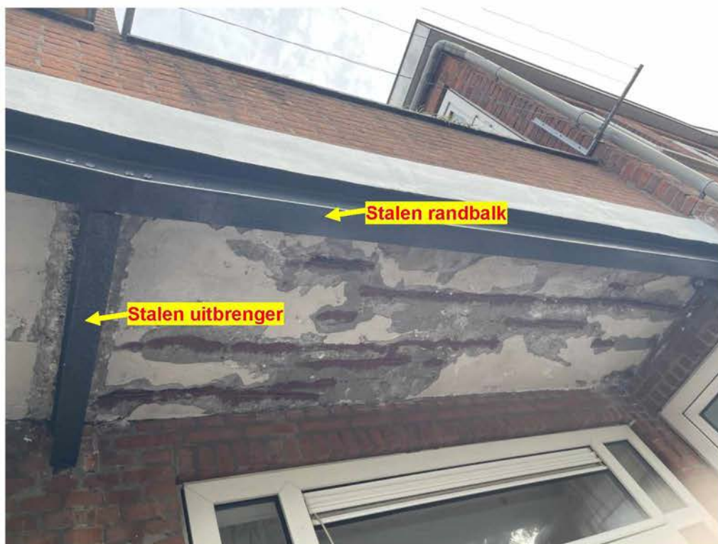
Foto 2. Locatie stalen uitbrenger (SU-1) met stalen balk onder randbalk.
