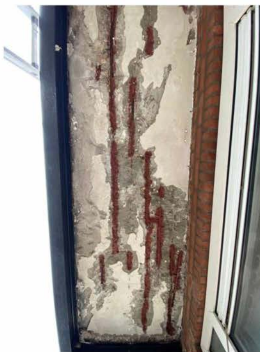
Foto 16. Onderaanzicht balkon 262 (corrosie hoofdwapening).
