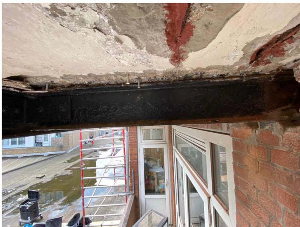
Foto 4. Locatie stalen uitbrenger (SU-1) aansluiting uitbrenger / gevel.
