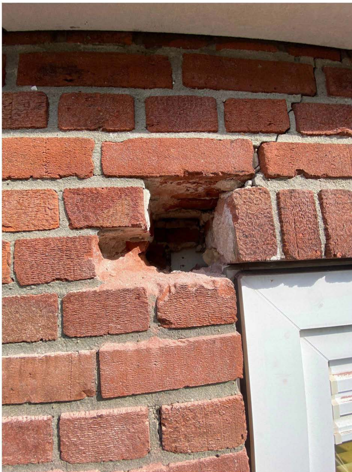
Foto 18. Locatie onderzoek gevelmetselwerk zonder aanwezige stalen latei (GL-1).
