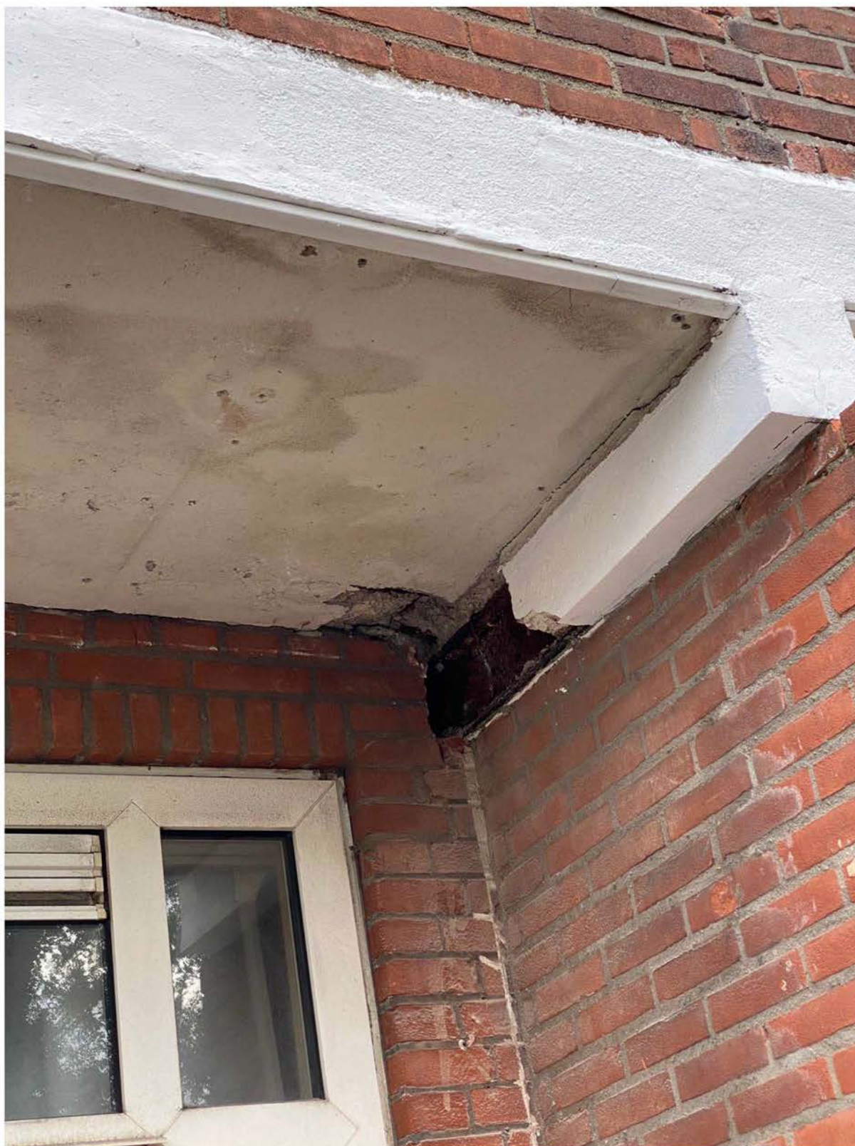
Foto 11. Locatie omhulde stalen uitbrenger (SU-2).
