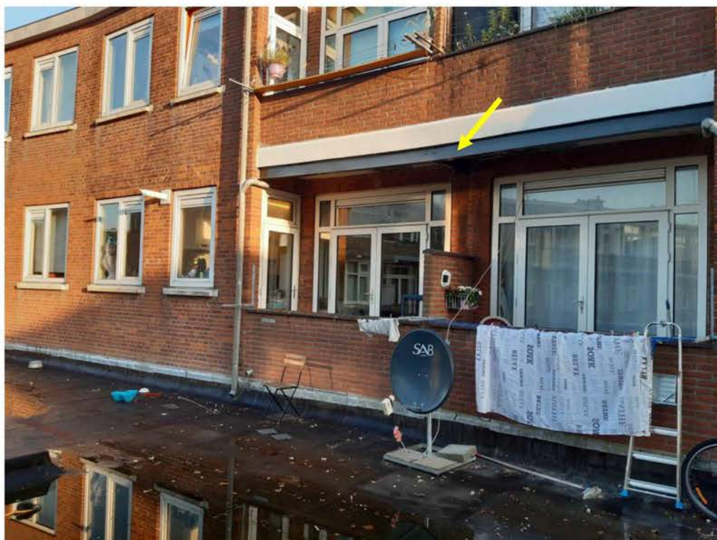
Foto 1. Locatie stalen uitbrenger (SU-1) met stalen balk onder randbalk.
