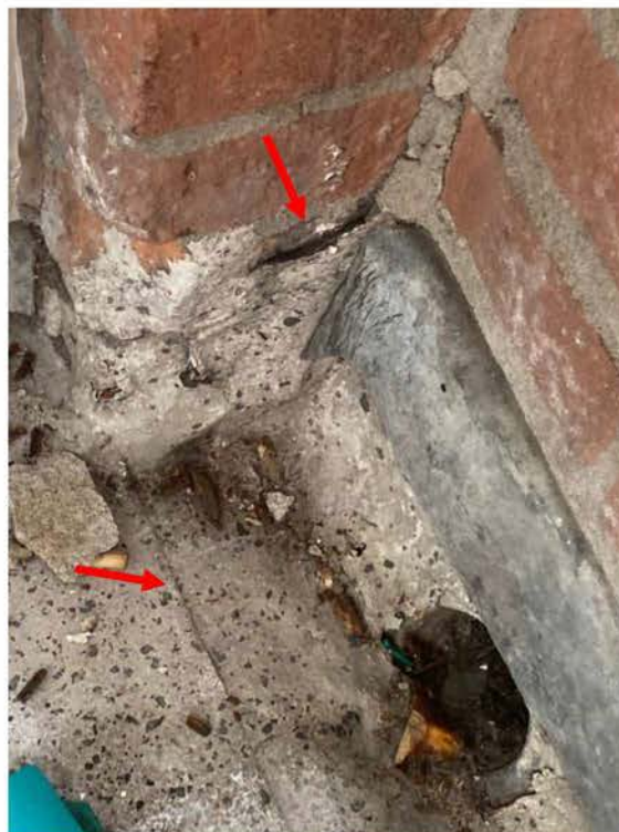
Foto 20. Defecte vloerafwerking balkon 264.
