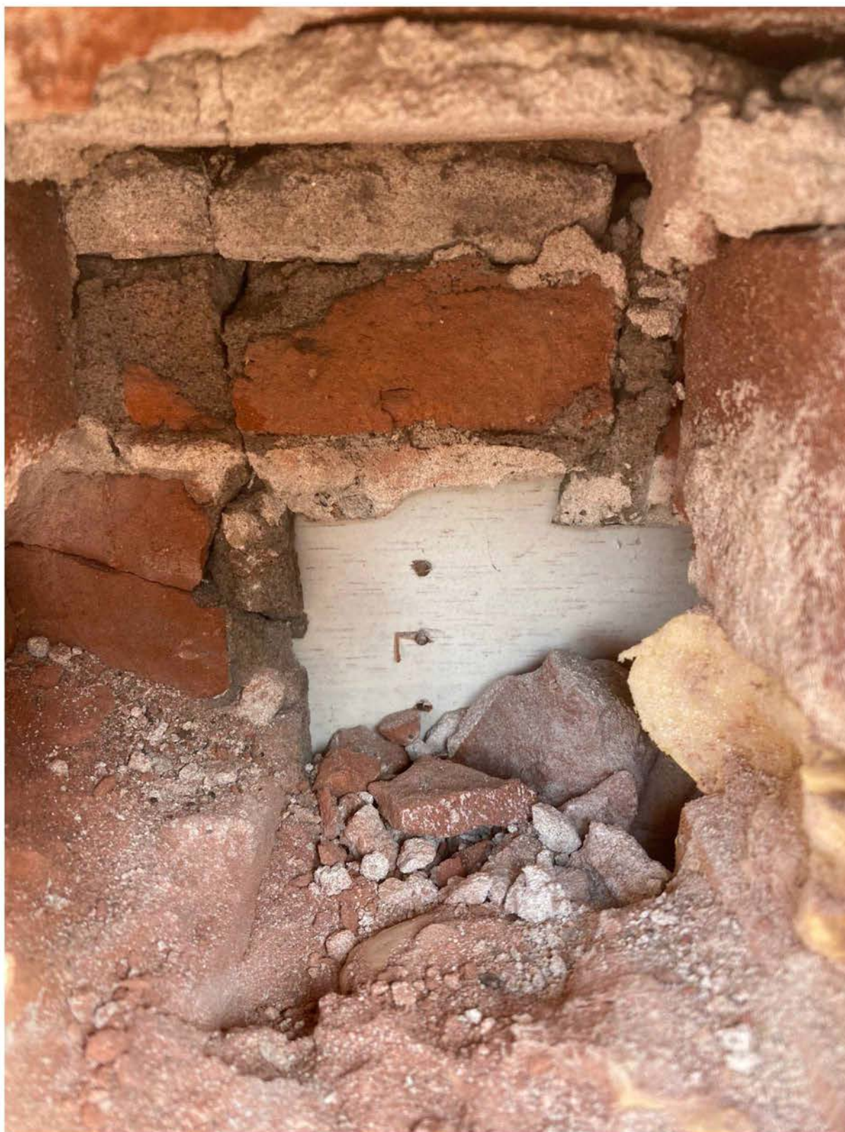
Foto 19. Locatie onderzoek gevelmetselwerk zonder aanwezige stalen latei (GL-1).
