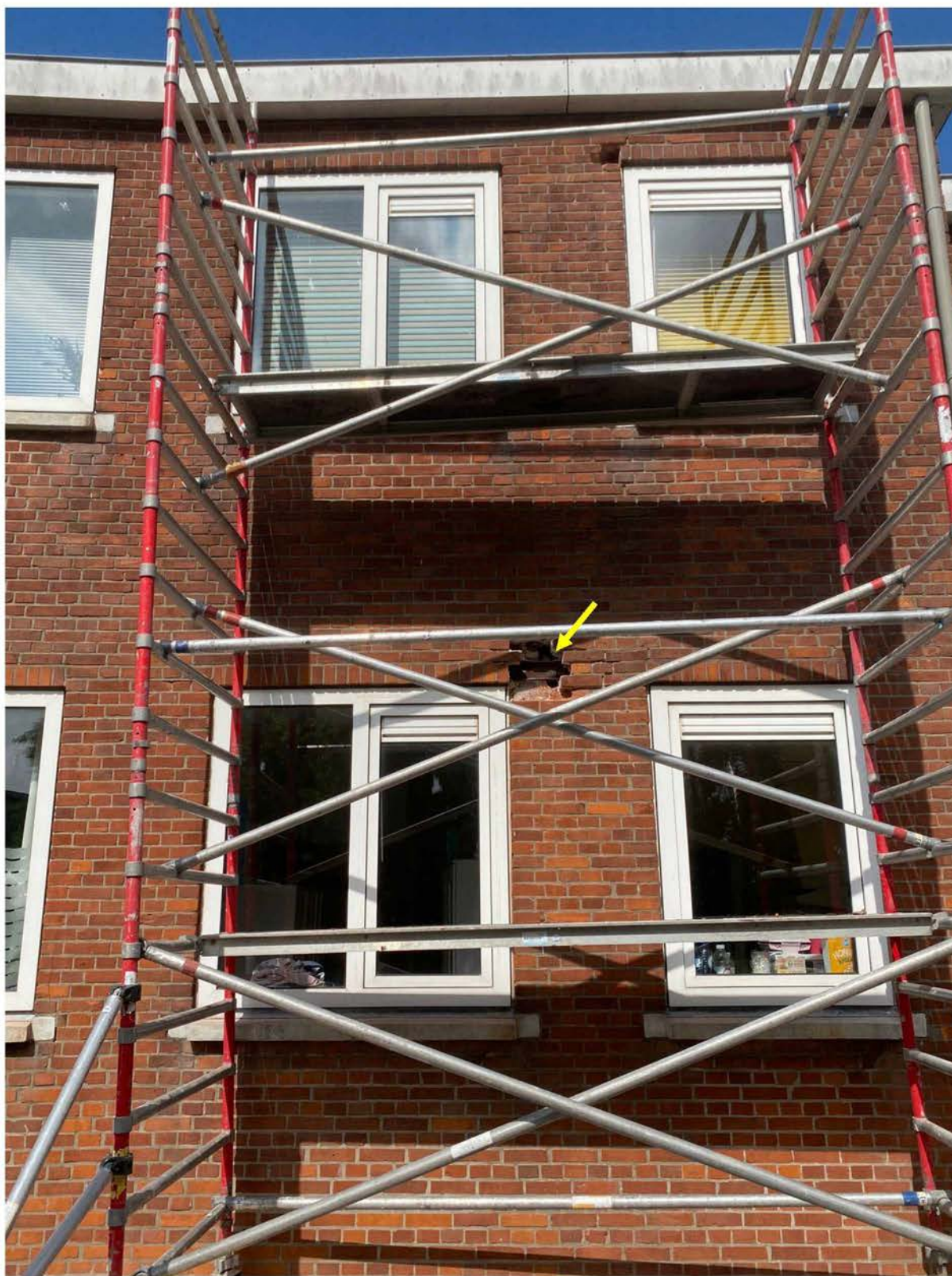
Foto 20. Locatie onderzoek gevelmetselwerk met aanwezige stalen latei (GL-2).
