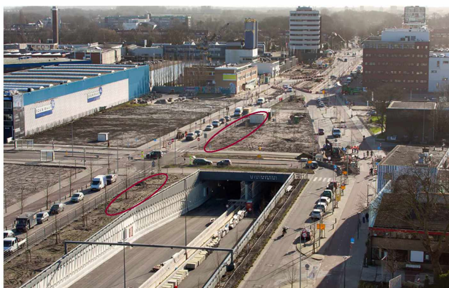
Figuur 2.5: Ter hoogte van de Zonweg gaat de Binckhorstlaan (hier in aanleg) ondergronds als Rotterdamsebaan; de mogelijke locatie van de haltes is aangegeven
