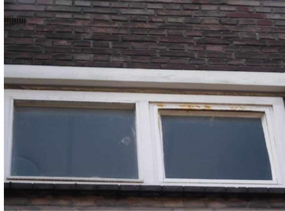
stalen ramen worden vervangen
