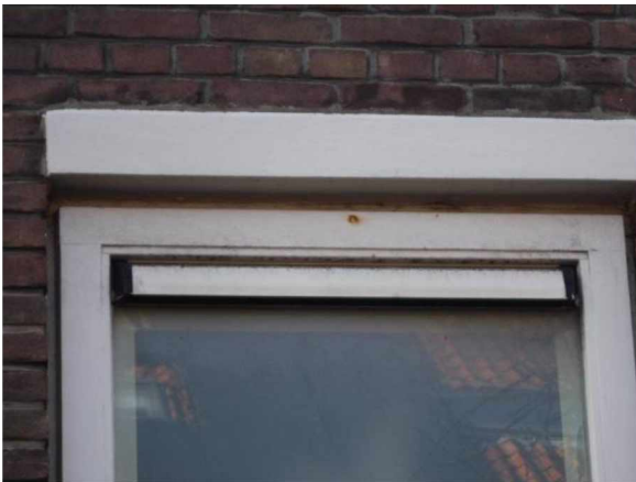
corroderend bevestigingsmateriaal
