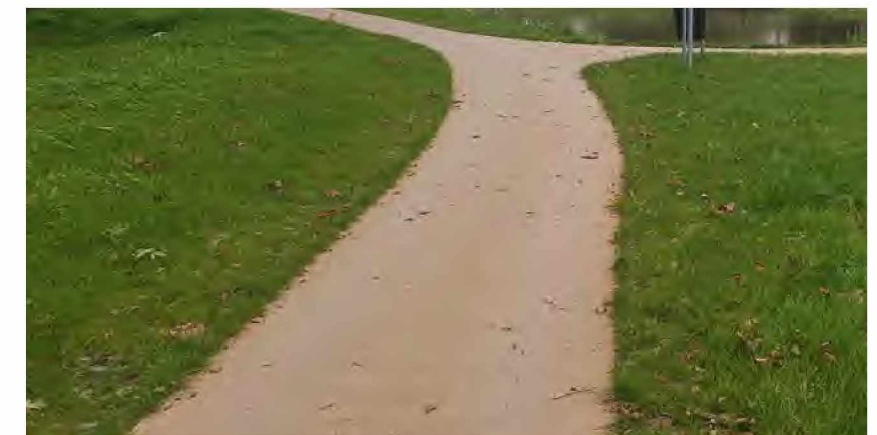
schelpenasfalt (asfalt met afgestrooide schelpen)
