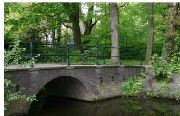
Sierlijke landgoedbrug van gemetselde wanden en smeedijzer railingen
