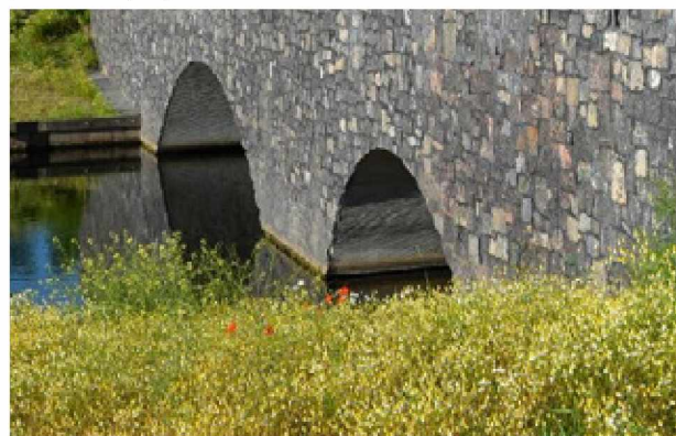
Nieuwe duikerverbinding ondergeschikt aan historische jaagbrug, vandaar afgewerkt met basaltblokken
