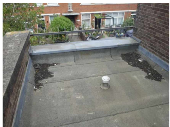
24: overzicht deel dakvlak
