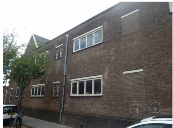
4: aanzicht zijgevel tpv dakvlak
