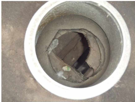
7: inkijk in ontluchting, insnijding onnodig
