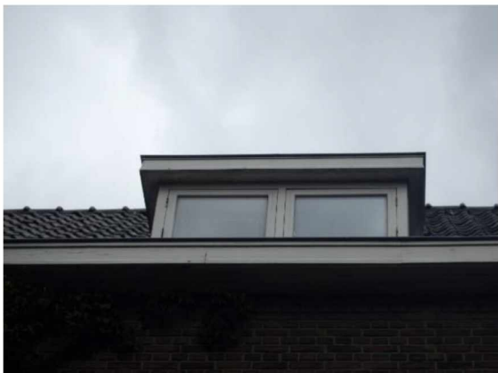
51: dakvlak F: aanzicht van een dakkapel
