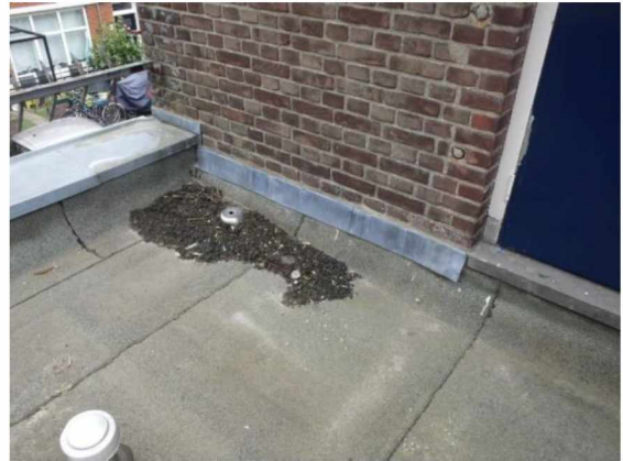
32: aanzicht opstandafwerking tpv gevel
