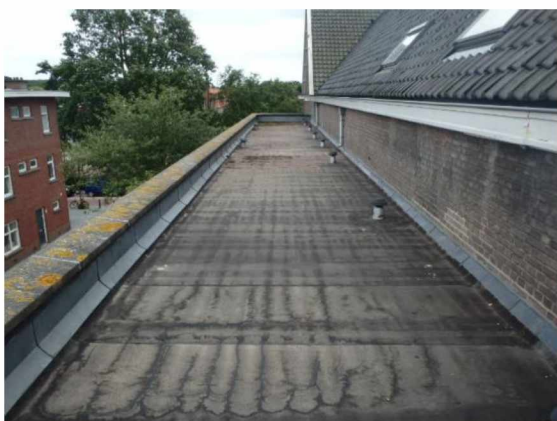
5: overzicht deel dakvlak
