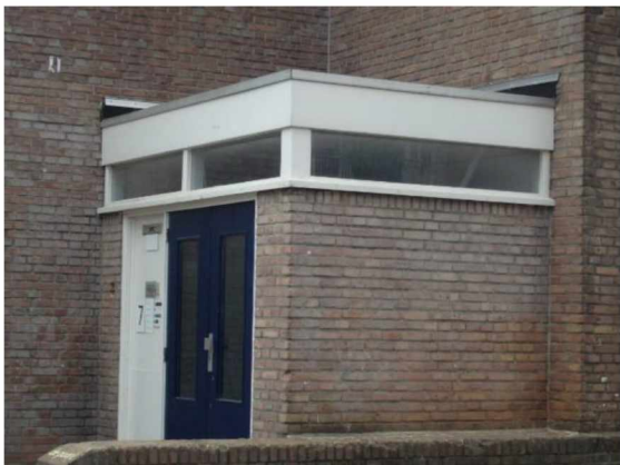
39: dakvlak C: aanzicht entreeportaal
