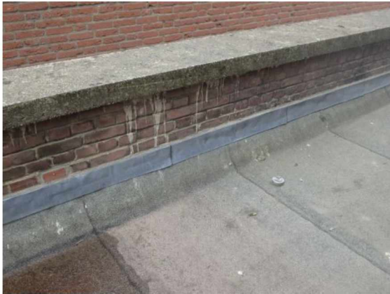
31: aanzicht opstandafwerking borstwering
