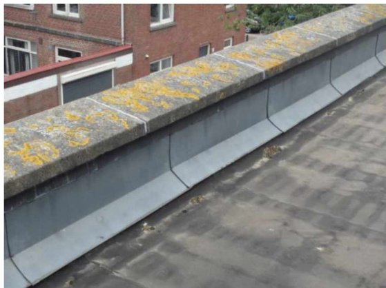
9: aanzicht langs dakrand
