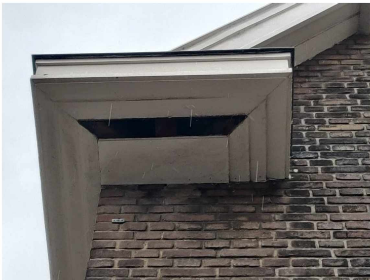
Figuur 5.2. Het gat in de dakoverstek aan de westkant van het gebouw.
