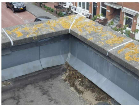
11: aanzicht dakrandafwerking tpv hoek
