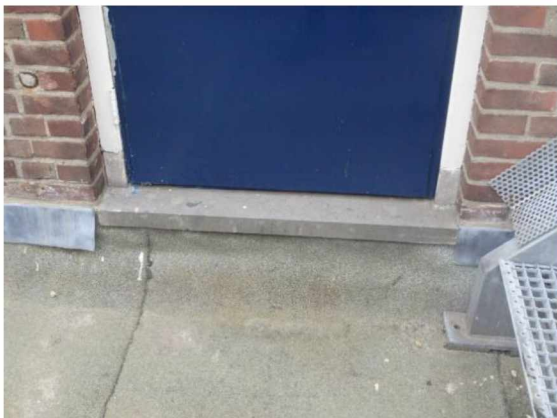
33: aanzicht opstandafwerking tpv deurkozijn
