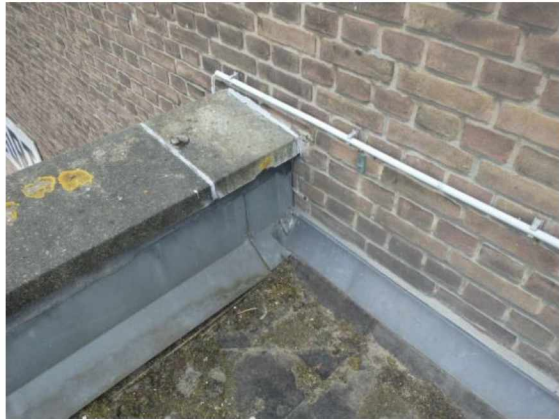
13: aansluiting dakrand tegen gevel
