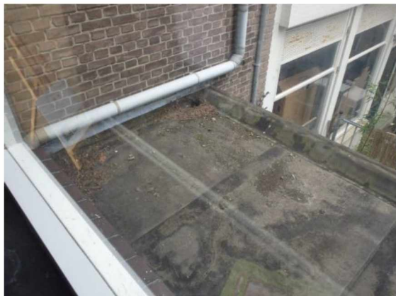
45: aanzicht deel dakvlak
