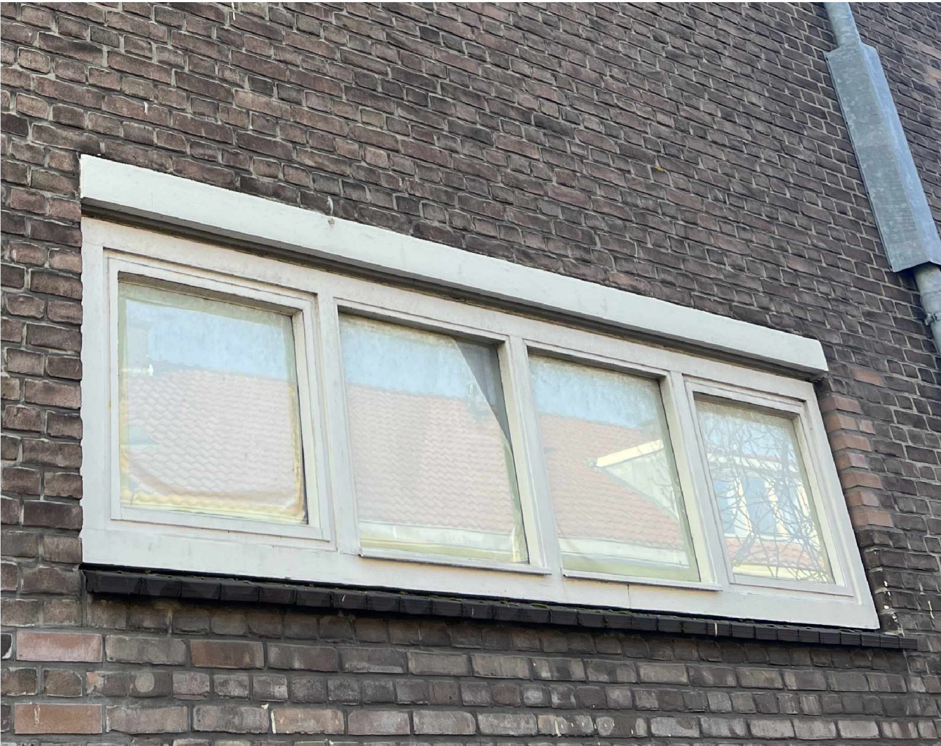
Kozijn Hout met stalen ramen t.p.v. gevel Hugo Verrieststraat
