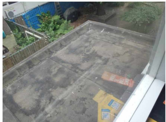
46: aanzicht deel dakvlak
