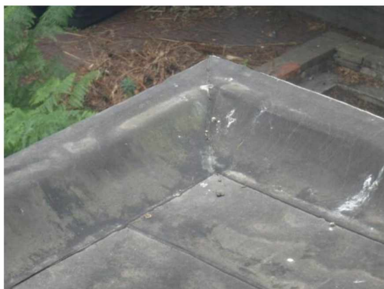
47: aanzicht dakrand (zonder afwerkprofiel)
