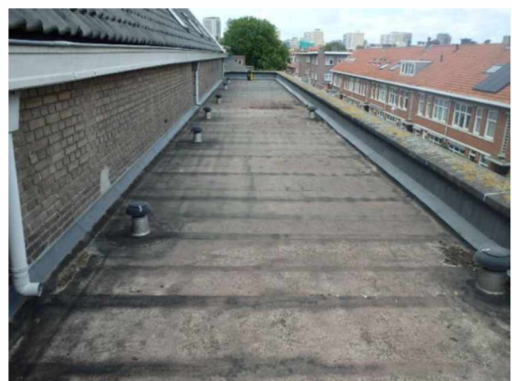
6: overzicht deel dakvlak
