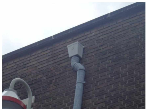
18: aanzicht vergaarbak en stalen hwa-pijp
