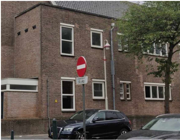
Figuur 5.1. Regenpijp aan de oostgevel waar een kap omheen zit.
