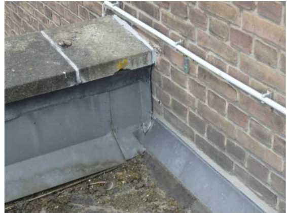
14: detail aansluiting dakrand tegen gevel
