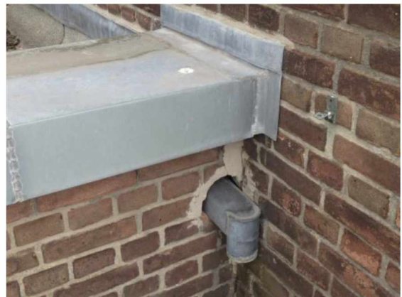
34: aanzicht hemelwaterafvoer in hoek
