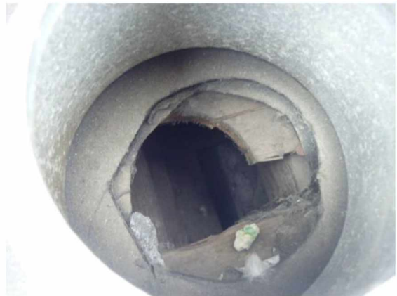
8: inkijk in ontluchting, insnijding onnodig
