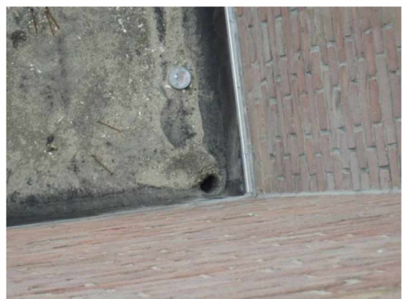
42: aanwezige hemelwaterafvoer
