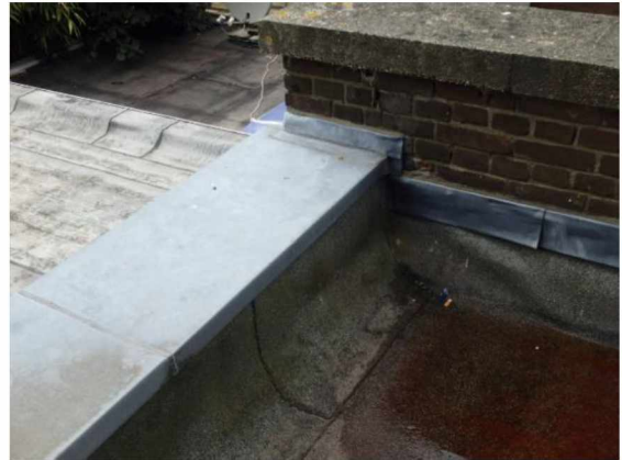
26: aansluiting dakrand tegen borstwering
