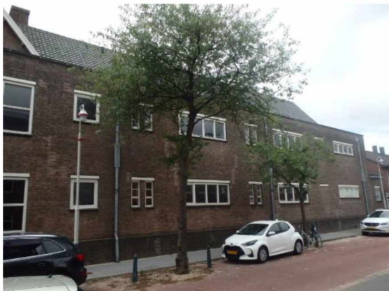
3: dakvlak A: aanzicht zijgevel tpv dakvlak
