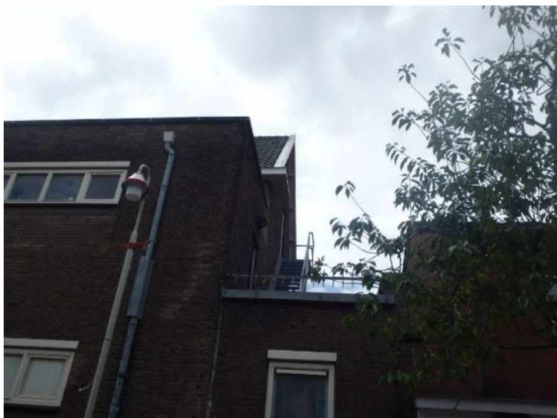
21: dakvlak B : aanzicht dakvlak
