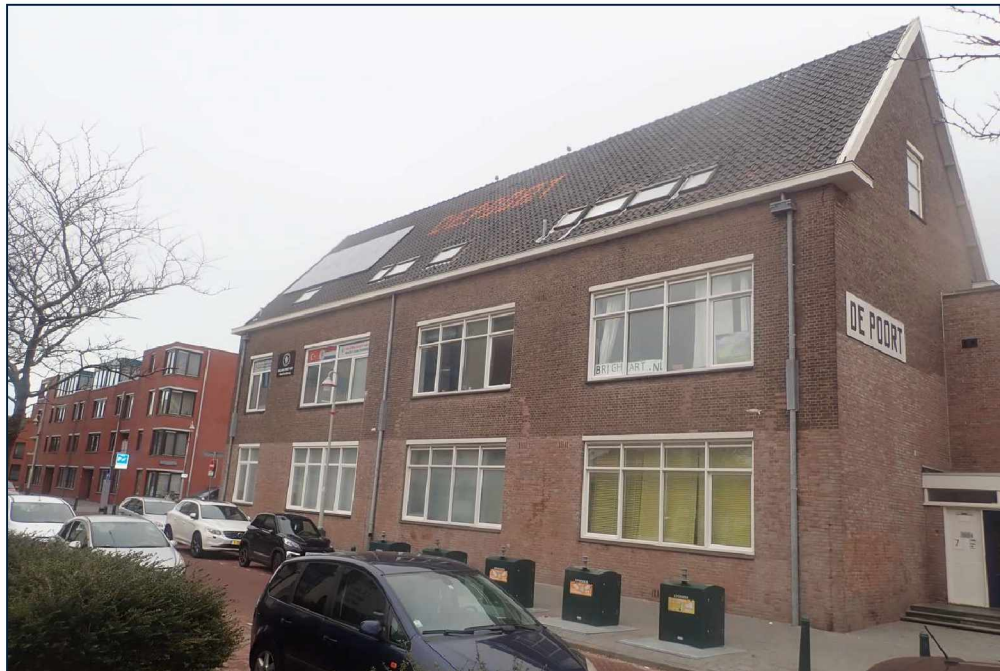
Figuur 3-2 Overzichtsfoto voorgevel (Zuidzijde)
