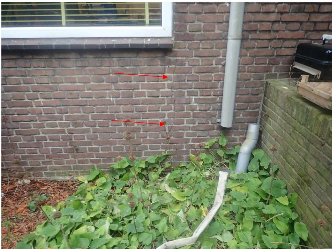
Foto 12 Scheurvorming gevel tuinzijde
