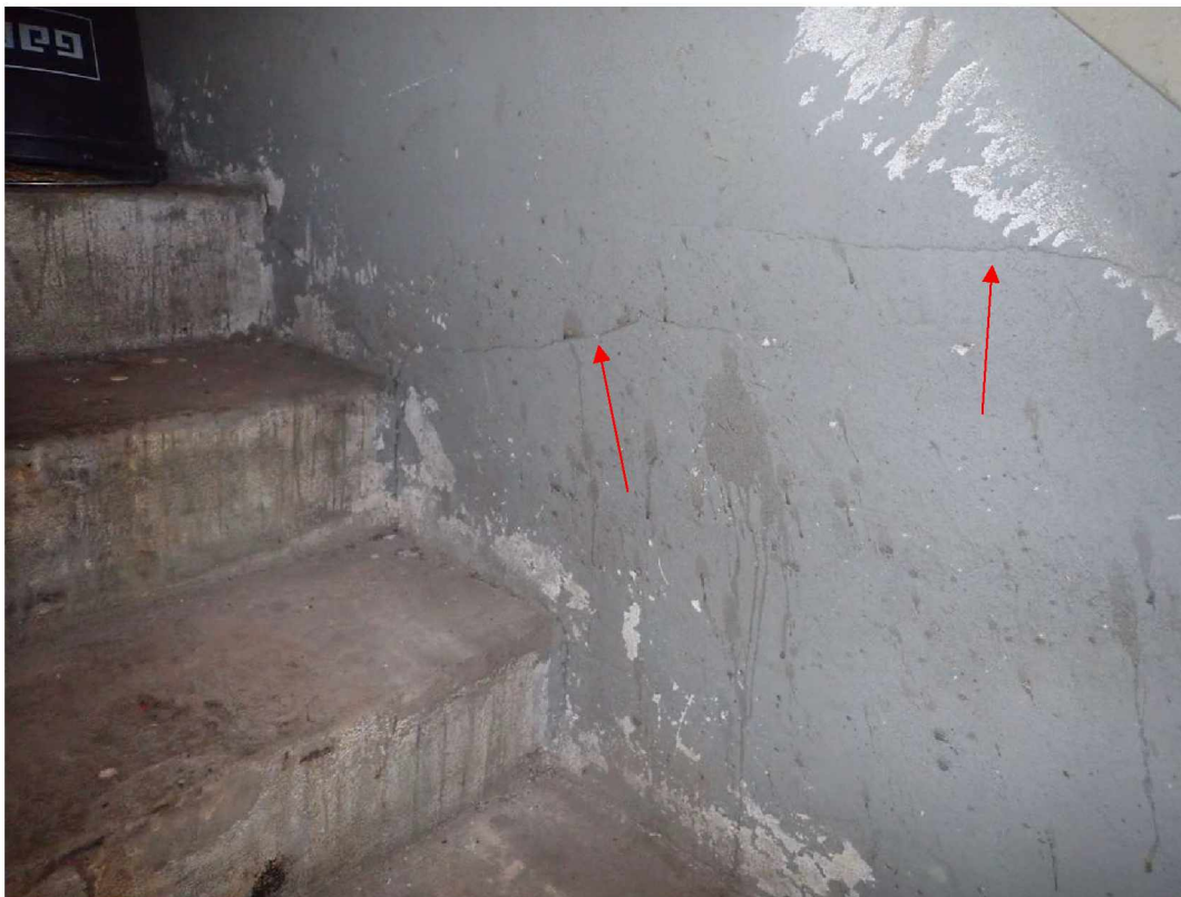
Foto 12 Scheurvorming gevel tuinzijde
