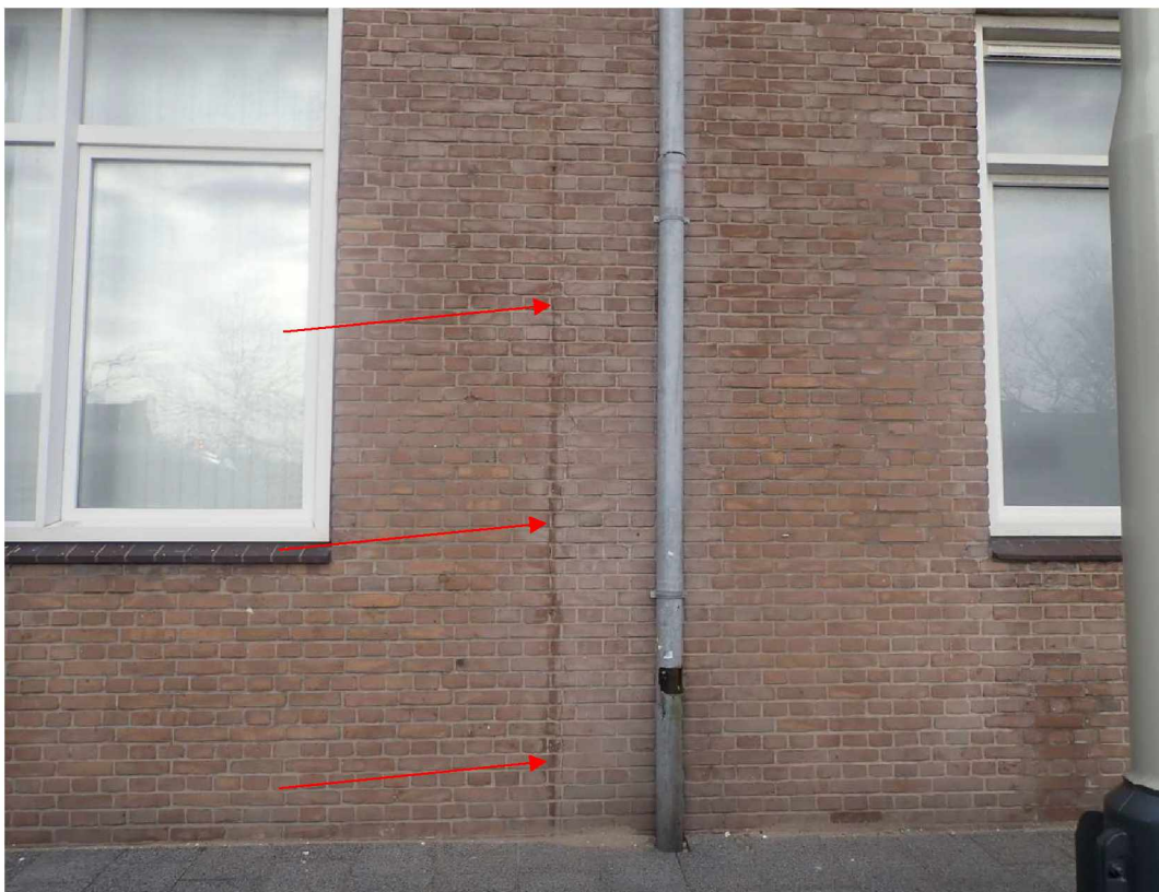
Foto 2 Scheurvorming zijde Ledeganckplein midden van zijgevel links
