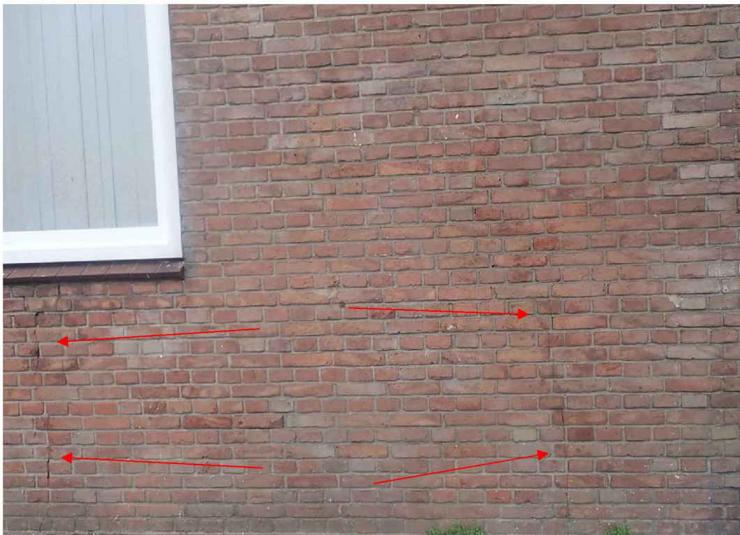
Foto 8 Scheurvorming hoek Guido Gezellestraat/Ledeganckplein
