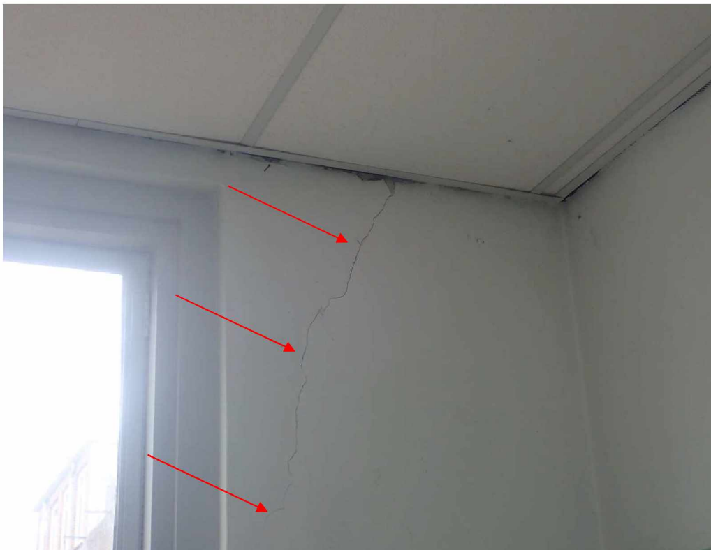
Foto 9 Scheur inpandig in de hal begane grond rechts van raam
