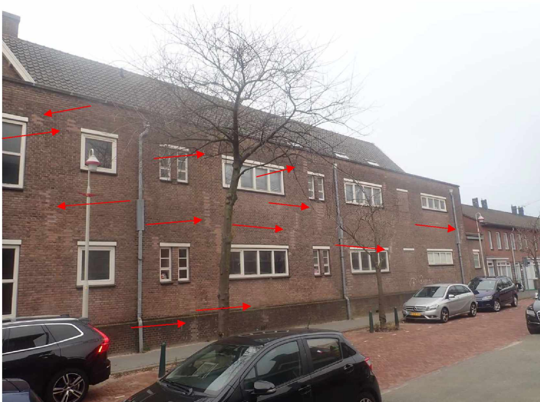
Foto 6 Scheurvorming zijde Guido Gezellestraat
