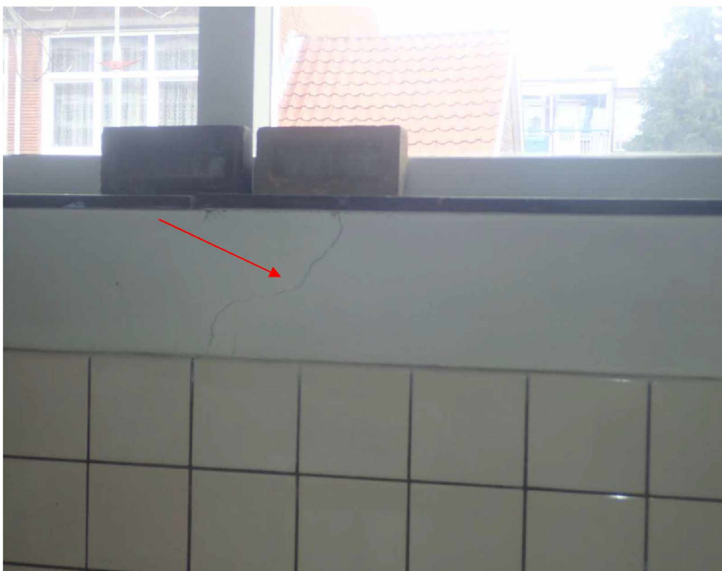
Foto 10 Scheur inpandig in de hal begane grond onder raam
