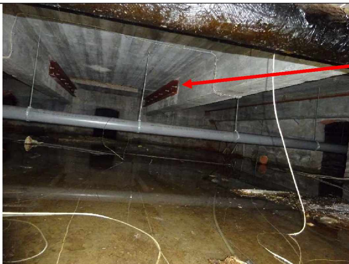
Foto 2: versterking van de betonbalken.
