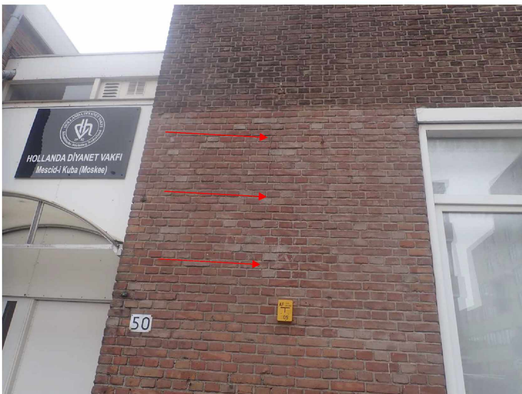
Foto 6 Scheurvorming zijde Guido Gezellestraat
