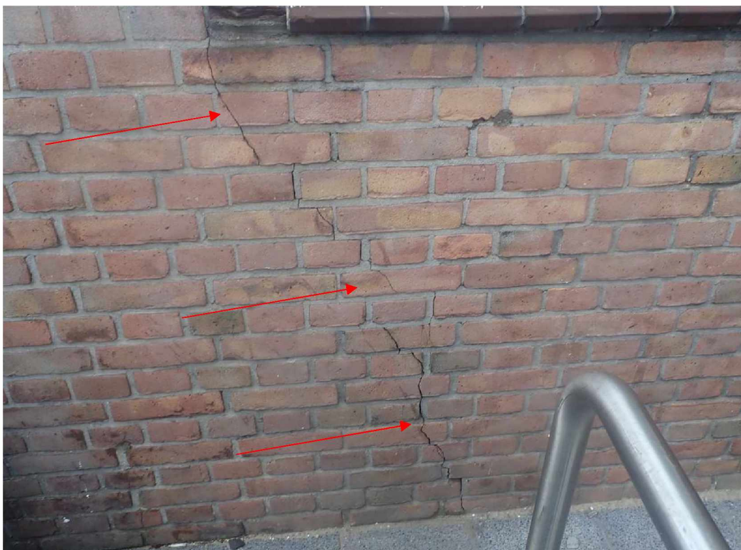
Foto 8 Scheurvorming hoek Guido Gezellestraat/Ledeganckplein
