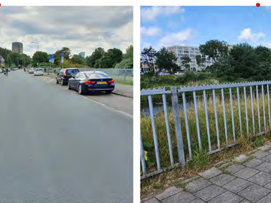
Overmaatse rijweg in asfalt
