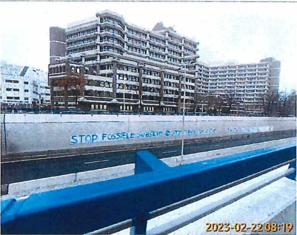
Rechter tunnel wand
