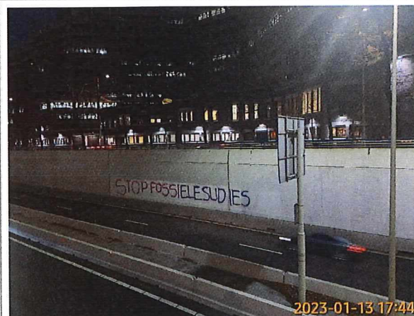
Rechter tunnel wand
