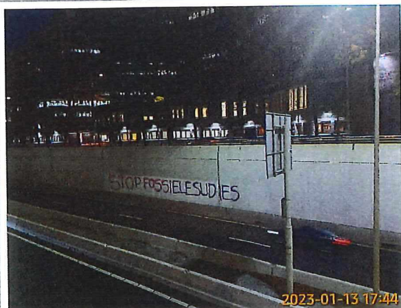
Rechter tunnel wand
