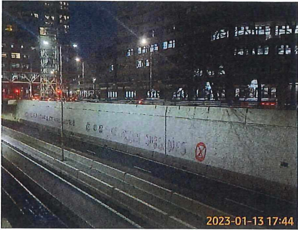
Rechter tunnel wand
