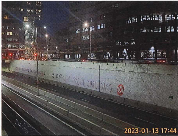
Rechter tunnel wand
