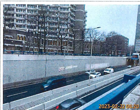
Rechter tunnel wand
