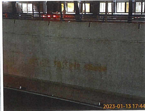
Rechter tunnel wand
