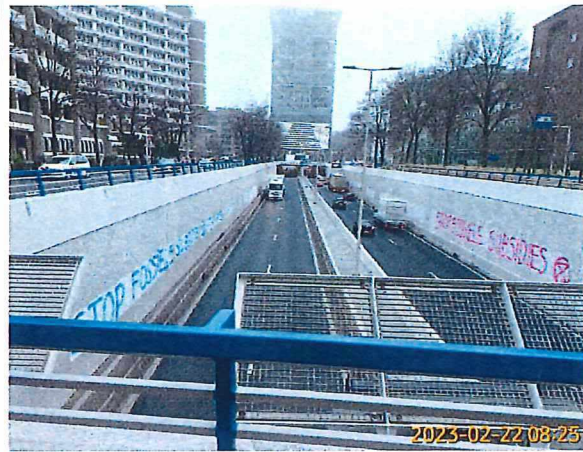
Overzichtsfoto beide tunnel wanden
