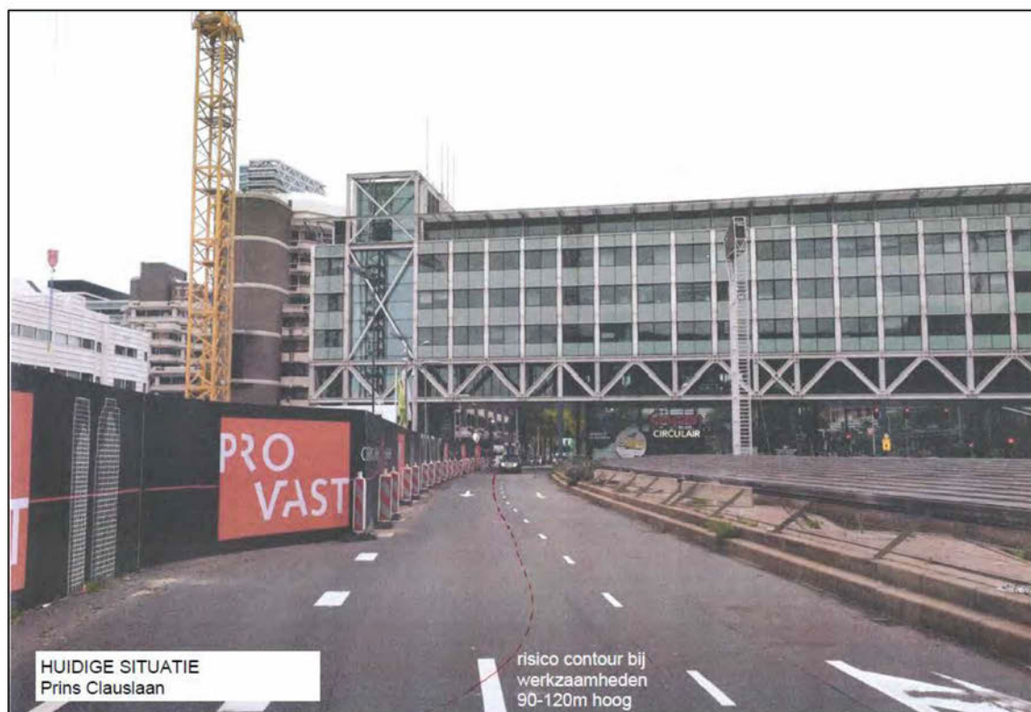
Afbeelding: huidige situatie Prins Clauslaan. Bouwveiligheidszone bevindt zich gedeeltelijk op de rijbaan – rijstrook 2.
